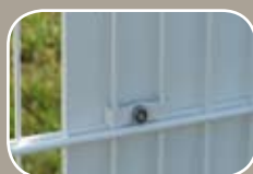
Adaptation de supports publicitaires par bridage sur le grillage
